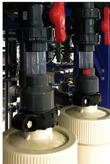
図 3: 確認用透明配管
