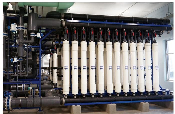
図 2: H2O Innovation, Inc. 社により設計・建設されたUF設備
