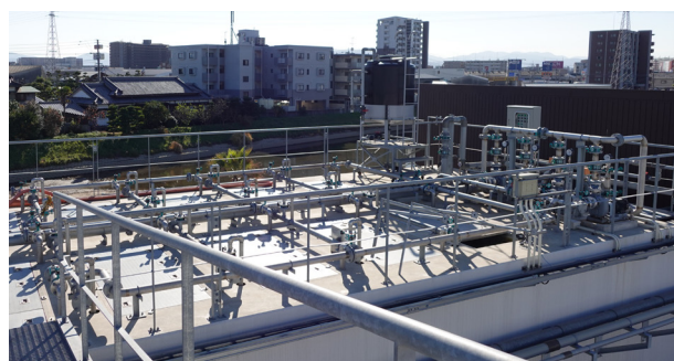
排水処理設備
