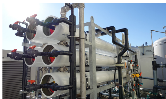
RO膜処理設備
