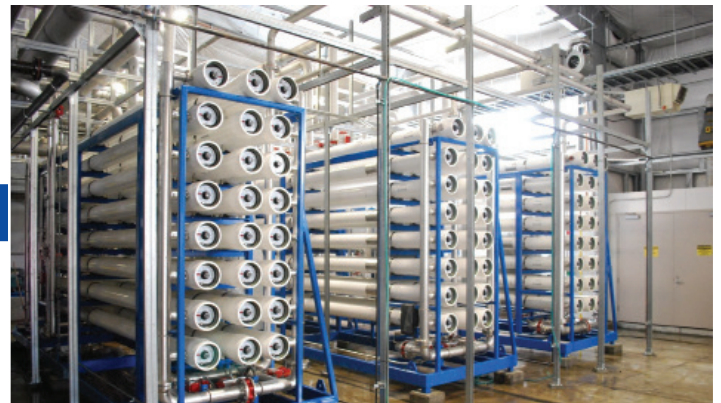
東レUF設備(VersaFilter™)およびRO設備 (写真提供 WesTech Engineering, Inc.)
