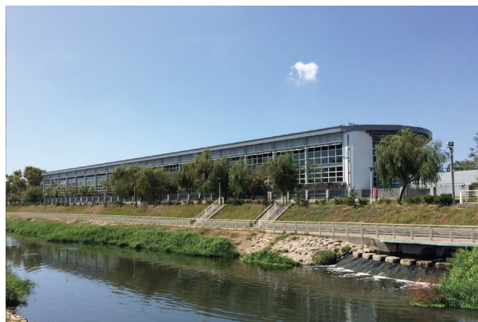
図 1: 鳳山区 (Feng Shan Xi) 廃水再利用設備
