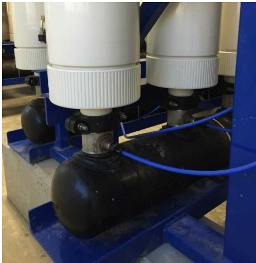
空気供給口の正しい接続例
